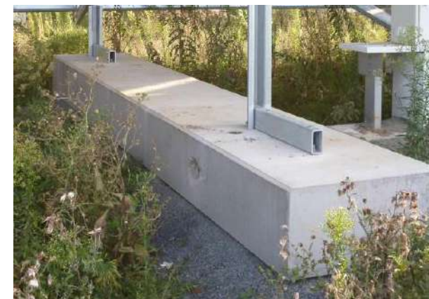
Semelles en béton
