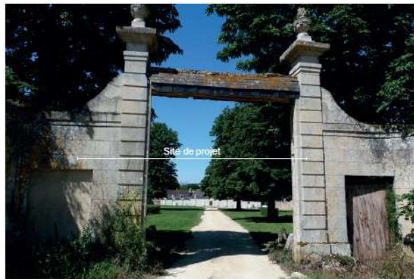
1. Portail et entrée principale du domaine de la Pinterie
