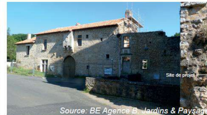
L'ancien logis abbatial (IMH) en restauration
