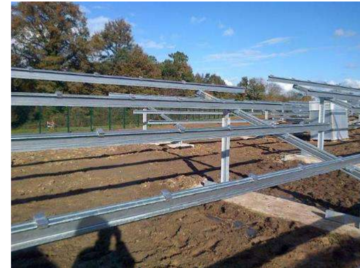
Fig. 23. Exemple de chantier de construction – Pose des structures
